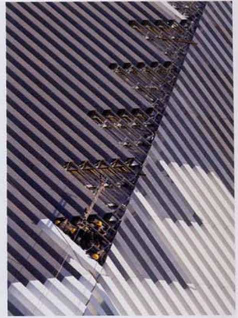
Le centre TVCC, Pékin. La toiture en partie basse du bâtiment.
