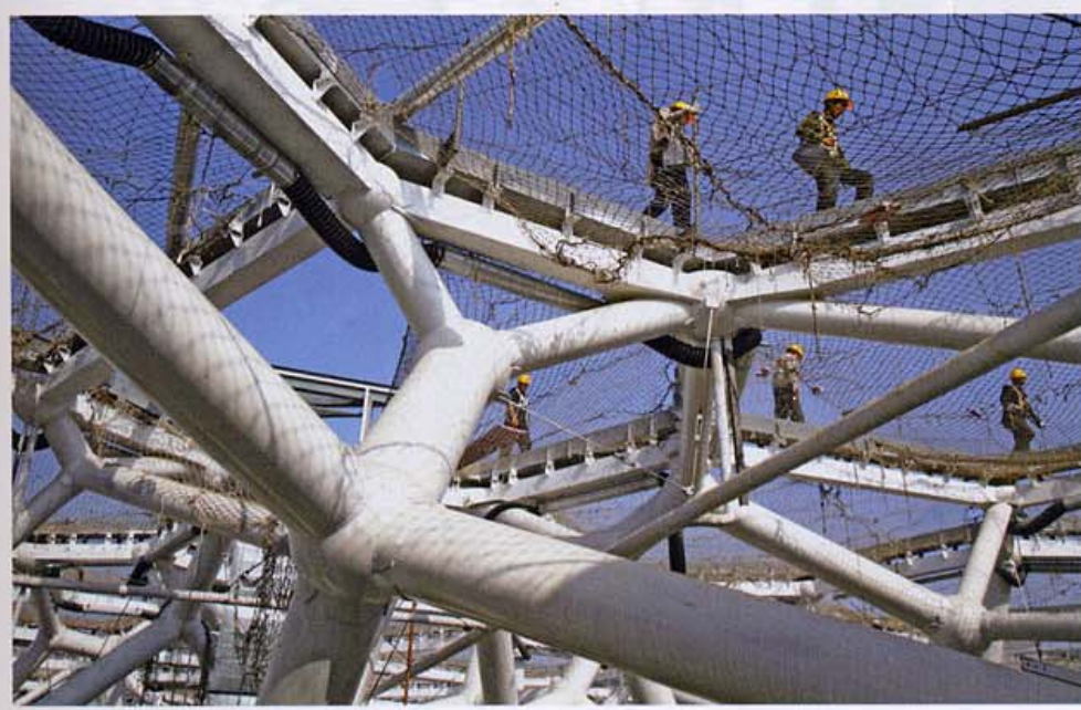
< La piscine olympique de Pékin, 2007. Agence PTW, architectes ; Ove Arup & Partners, ingénieurs. Façades et détail des coussins brevetés ETFE, aux géométries multiples. ^ Vue du chantier. Au second plan, le stade olympique de Herzog & de Meuron. v Vue d'un nœud structurel.
